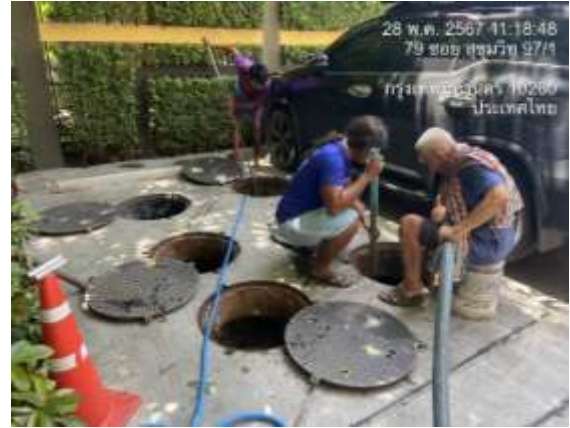
การดูแลก่อนของระบบบำบัดน้ำเสีย
