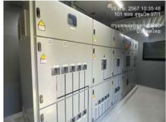
ห้อง MDB และ ป้ายแสดงถึงอันตรายไฟฟ้าแรงสูง
