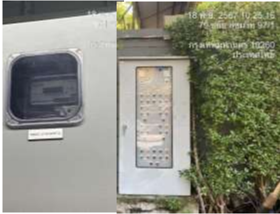
มิเตอร์ และ ตู้Control ของระบบบำบัดน้ำเสีย
