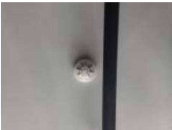
เครื่องตรวจจับความร้อนระบบ
